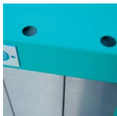
Korrosionsschutz durch V2A und Hinterlüftung
